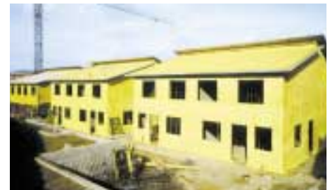
Aislamiento con espuma de proyección de PU (amarillo) en edificios domésticos
